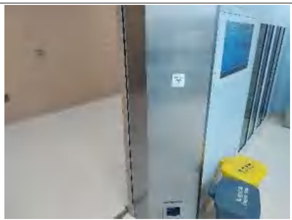
图 3-16 机房防护门红外防夹装置
