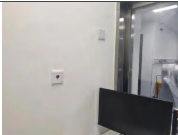
图 3-12 控制室内停机按钮
