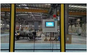
图 4-10 研发区固定式场所辐射探测报警装置
