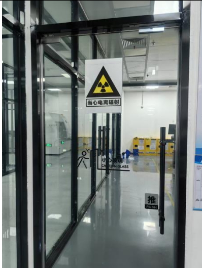
图 3-2 2 号 CT 室门上电离辐射警告标志
